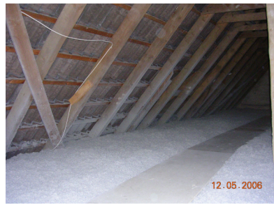
Abb. 3: Aufgeständerte Laufspur für die Begehbarkeit
