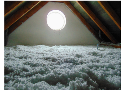
Abb. 2: Einblasdämmung auf die Dachboden- oder Kehlbalkenfläche, ohne Begehbarkeit
