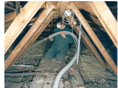
Abb. 6: Der Einblasvorgang zur Dachbodendämmung
